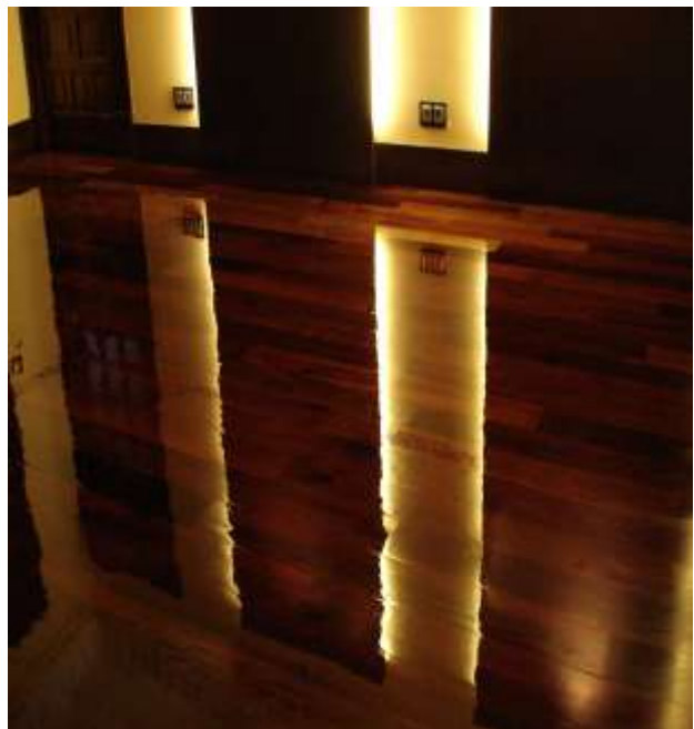
Acuchillado y barnizado de madera natural
