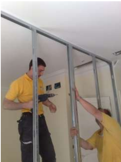
Tabiquería de medianería en placa de cartón-yeso Pladur.
