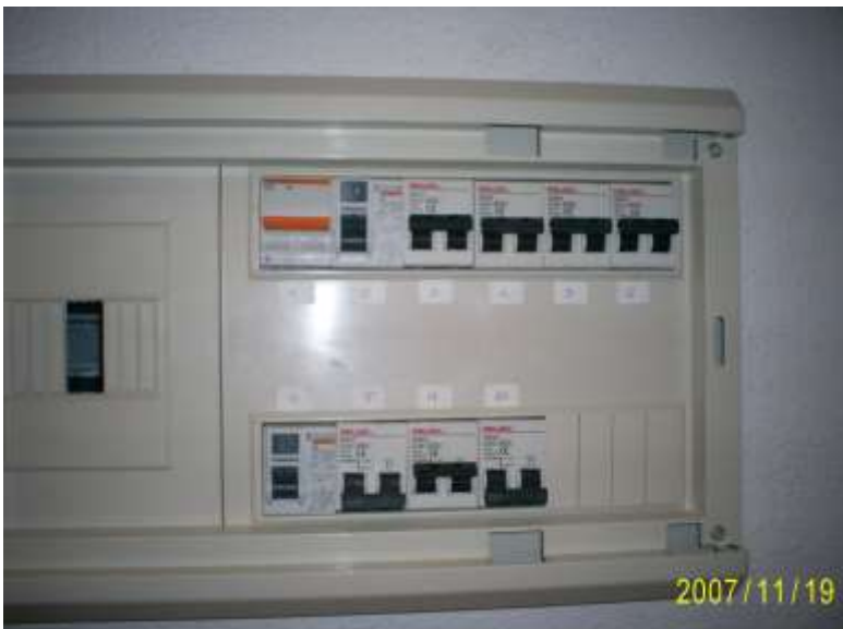
Realización de cuadro eléctrico de vivienda según normativa vigente de media y baja tensión.
